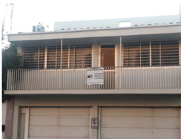
Figura 2. Señalética de moderación de ruido en fachadas del Centro Histórico
